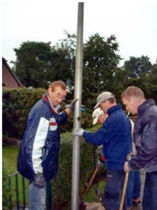
„Ist das jetzt endlich gerade?“
